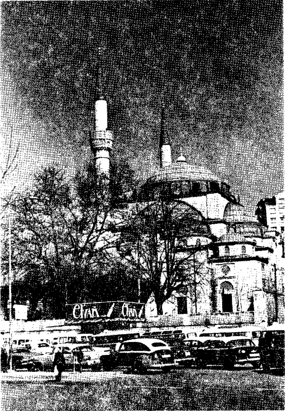
Resim 2 : Camiin batı cephesi.
