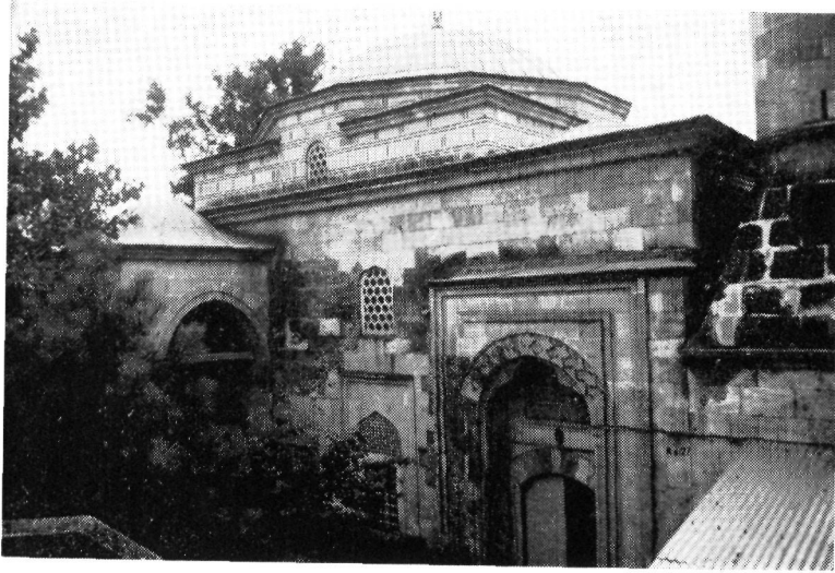
Res. 1- Şah Melek Camii, doğu cephe.
