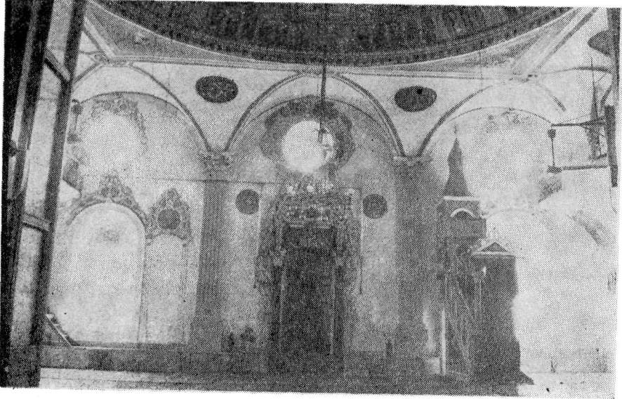
Res. 8- Kırkağaç Çiftahanlar Camii, Mihrap Duvarı
