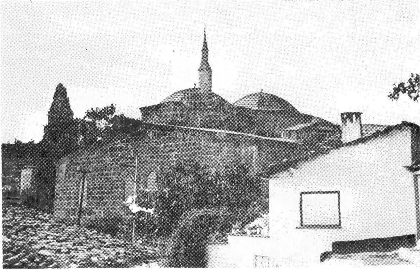
Res. 4— Bergama Ulu Camii, gúney cephe.
