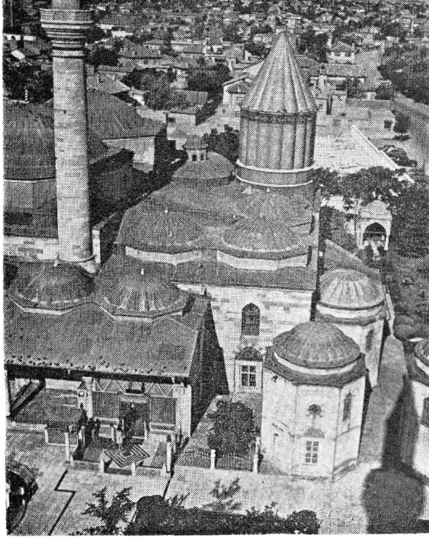
Res. 1- Konya Mevlâna Türbesi. Genel görünüş.
